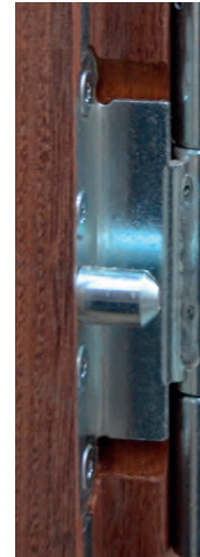
DETAIL TRŇOV PROTI VYSADENIU
